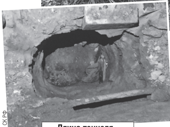
Длина тоннеля - около 65 метров.
