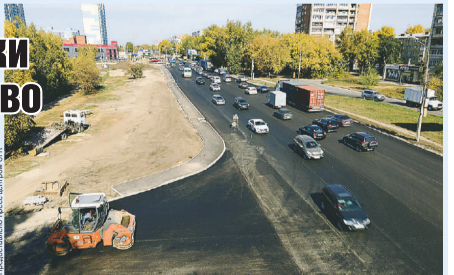
Благоустройство дорожного полотна после работ на улице Троллейной.
