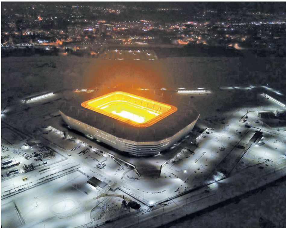
Так наша арена выглядит прямо сейчас. Необычное свечение создают фитолампы, включенные для роста и поддержания натурального газона.
