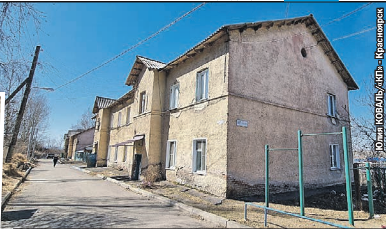
В районе, где живет Сева, отремонтирован только вокзал. Остальное держится на честном слове.
