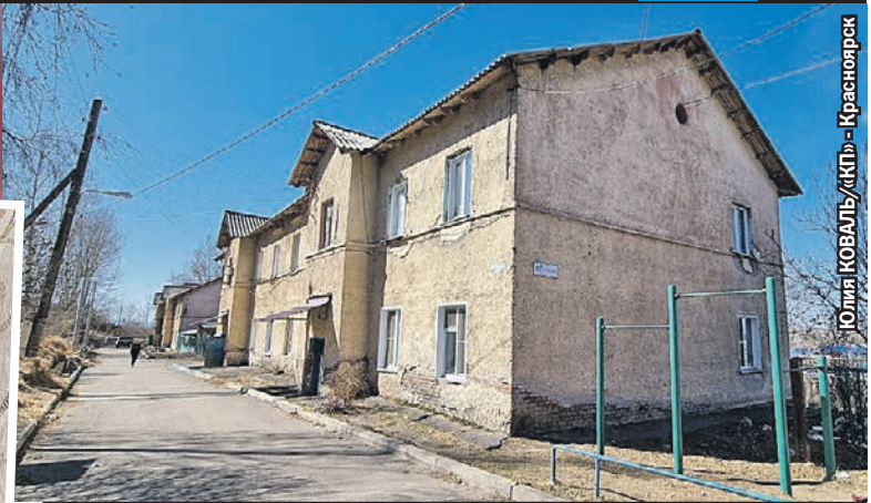
В районе, где живет Сева, отремонтирован только вокзал. Остальное держится на честном слове.
