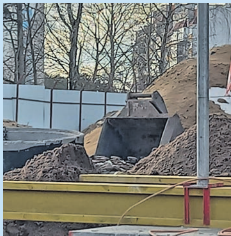
По предварительным данным, ковш сорвало при повороте стрелы.
