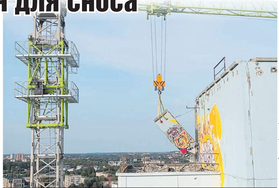
Демонтаж верхних этажей идет с конца сентября. Теперь темпы должны увеличиться.
