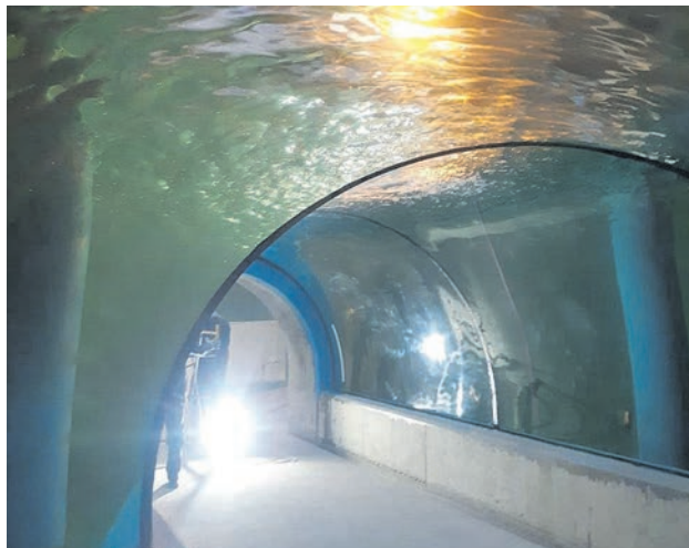
Сквозь один из аквариумов проходит тоннель, изготовленный из специального акрилового стекла.
