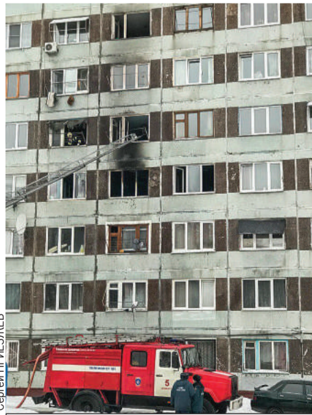
Возгорание произошло в комнате на четвертом этаже.
