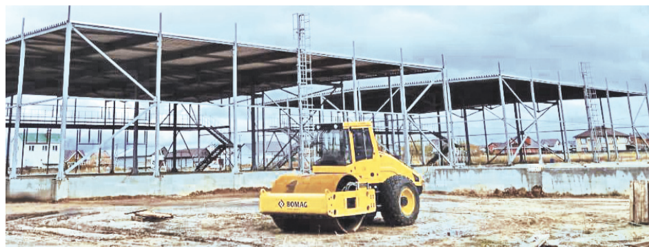
Первые шесть из одиннадцати строящихся зданий общей площадью около 8 тыс. кв. м планируется ввести в эксплуатацию в начале I квартала 2025 года.
