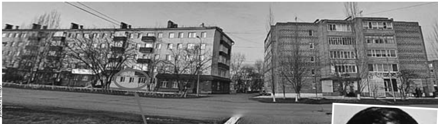
В квартире на первом этаже этой хрущевки и скрывался беглец.
