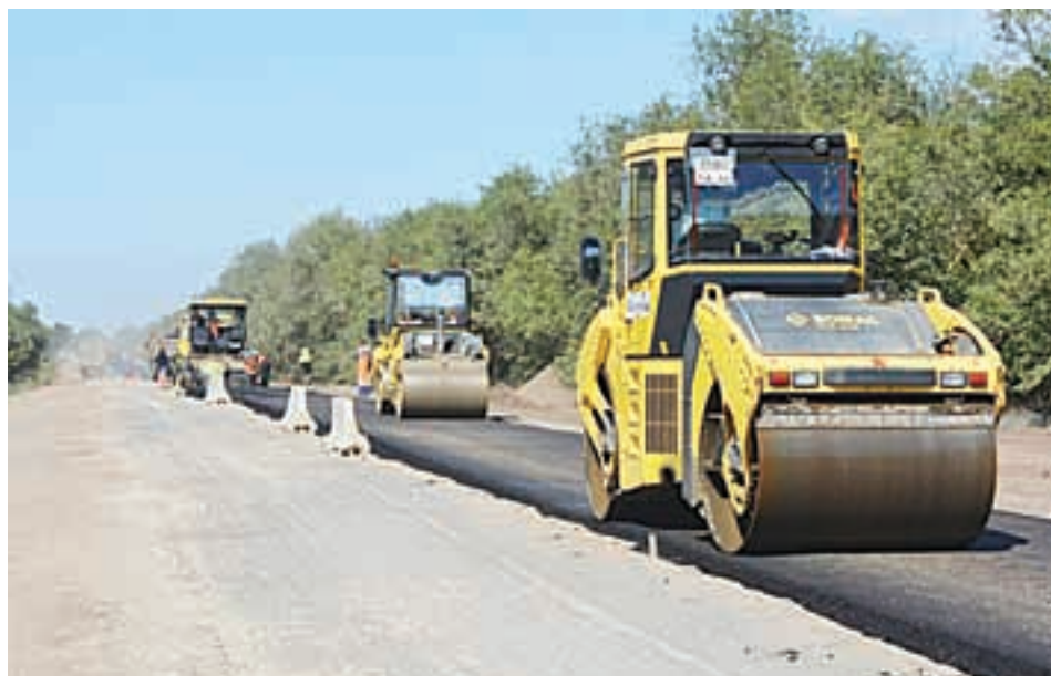
Ремонт дорог ведется одновременно в нескольких районах Саратовской области.
