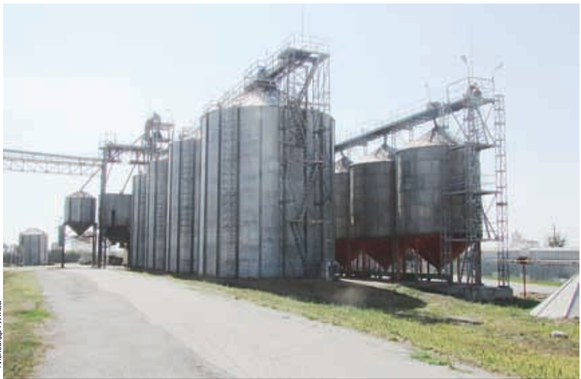
Хранилища элеватора ООО Агрофирма «Рубеж», введенного в эксплуатацию в 2019 году.
