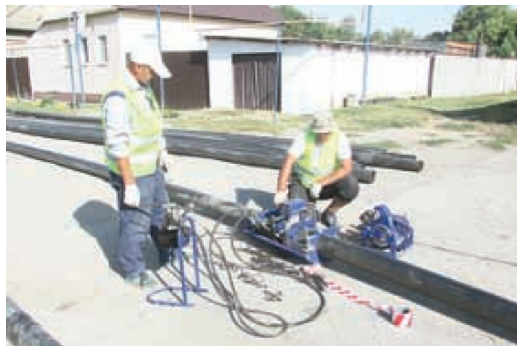
Продолжаются работы по замене водопровода в селе Березово.
