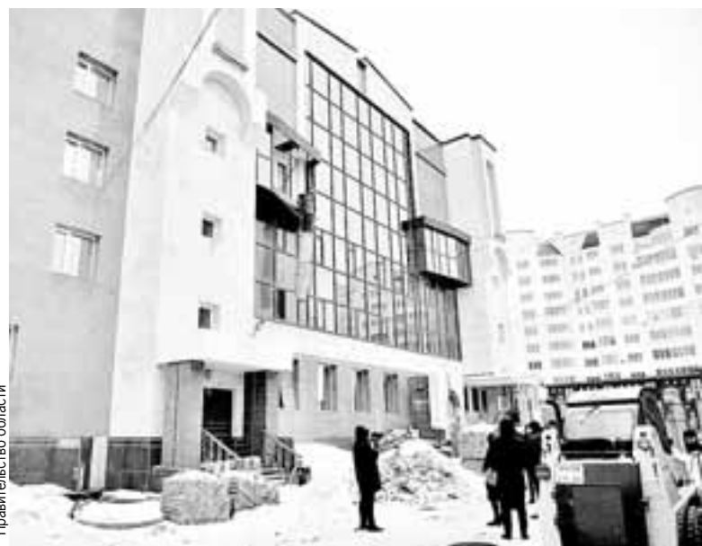
Совещание прошло на стройплощадке.
