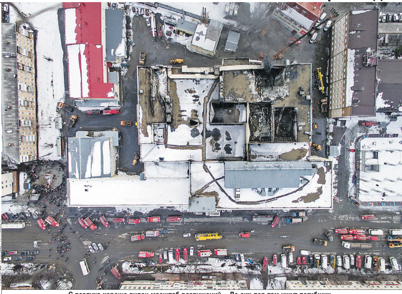
С воздуха хорошо виден масштаб разрушений... До сих пор там ищут погибших...
