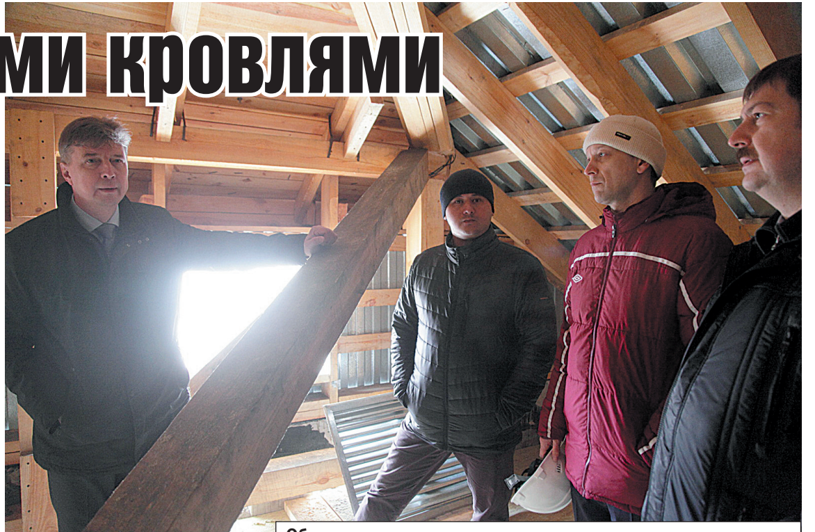
Областные власти считают, что после капитального ремонта хрущевки в Томске прослужат еще десятки лет.
