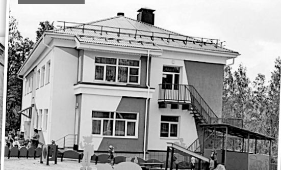
Эффект от частных инвестиций в соцсферу моногородов налицо (на фото - карабашский детский сад № 9, реконструированный на средства РМК).
