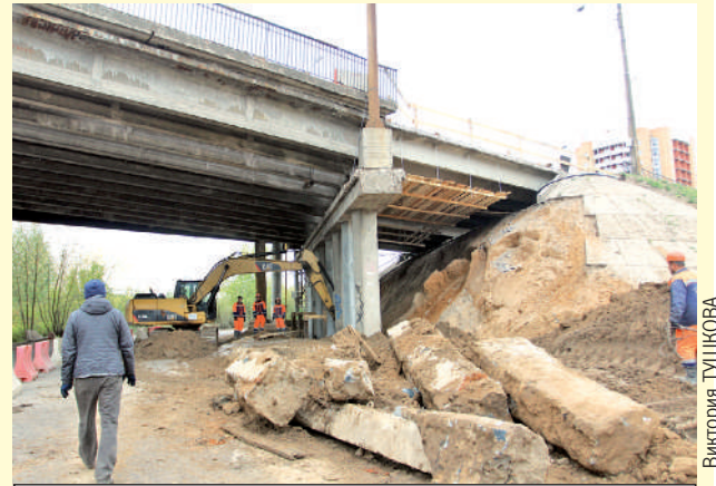
Фото сделано в самом начале ремонтных работ. Тогда ещё все шло по плану.
