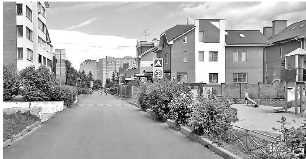
Уже сейчас, в первых числах августа, почти на половине объектов завершена укладка верхнего слоя асфальтобетонного покрытия.
