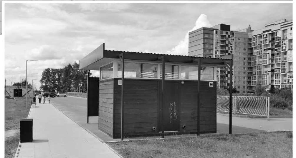
Туалет установлен, но не доделан, видимо. Не работает, двери закрыты.
