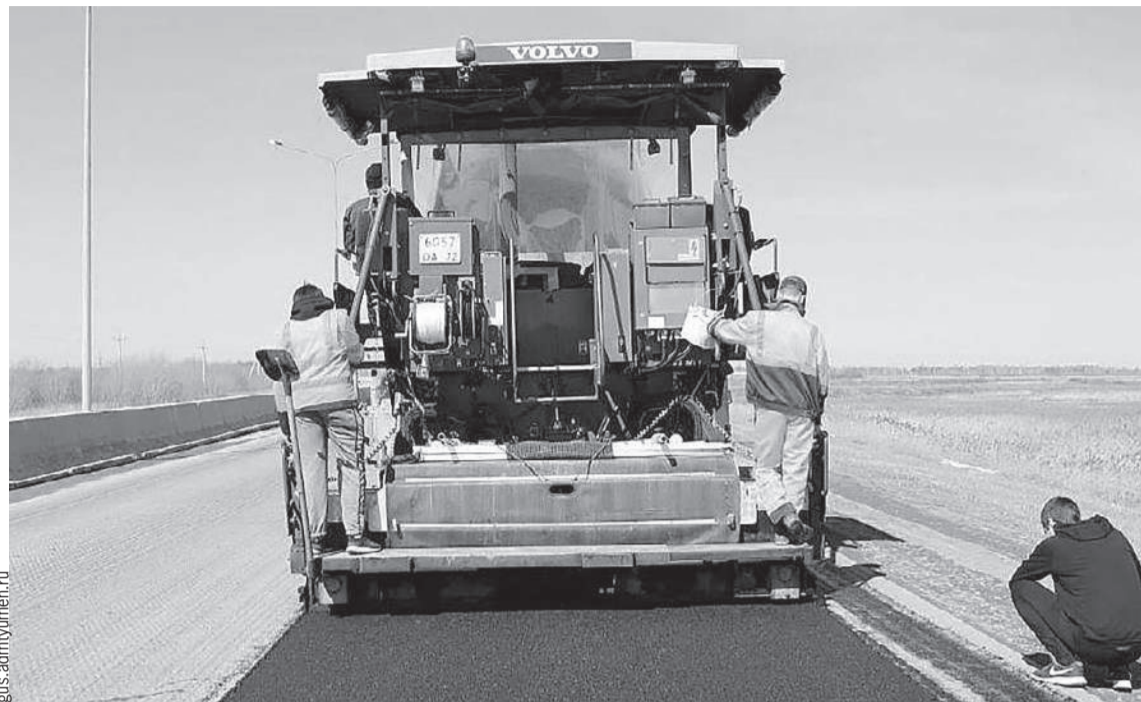
Дороги Тюменской области ремонтируют с применением современных технологий.
