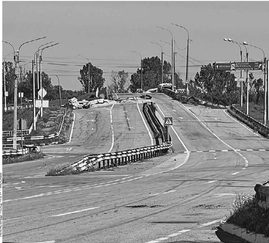
Подъезд с левой стороны Днепра к единственному мосту на Херсон. Сейчас переправы здесь нет. Мост давно взорван.
