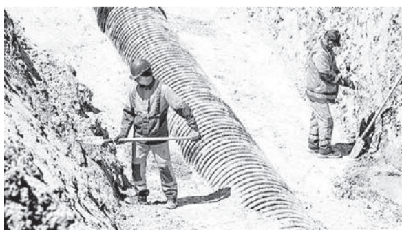
Компания обеспечит микрорайон дорожной и инженерной инфраструктурой.
