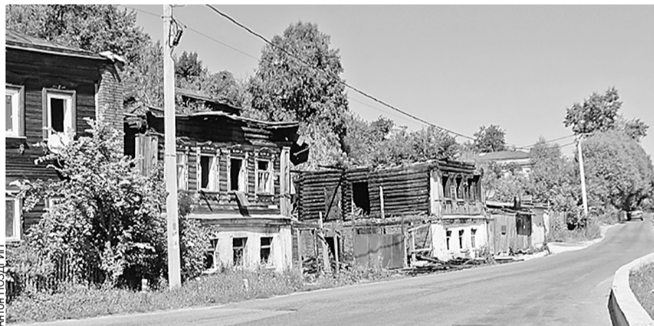
Дома №7 и №9 на улице Урицкого сожгли. Соседний дом пока цел.
