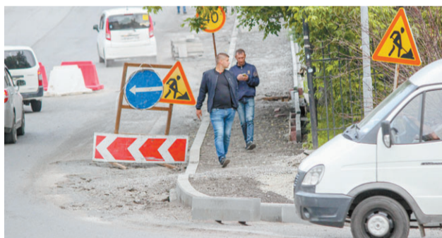
На Эгершельде скоро начнется комплексный ремонт еще на одной улице.
