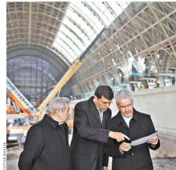
Сейчас в павильоне, построенном в 1939 году, работает тяжелая техника.
