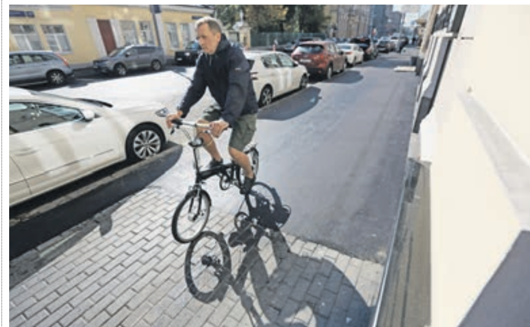
Вчера 12:10 На улице Пречистенке около домов № 38–40 уже работы по замене плитки на асфальт закончатся на этой неделе
