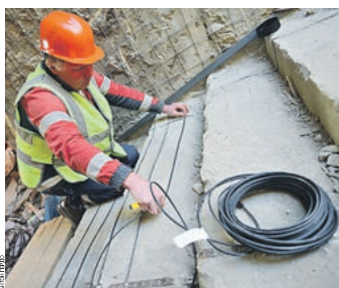
Вчера 15:44 Электромонтер Евгений Гологуш укладывает нагревательный кабель на ступенях подземного перехода
