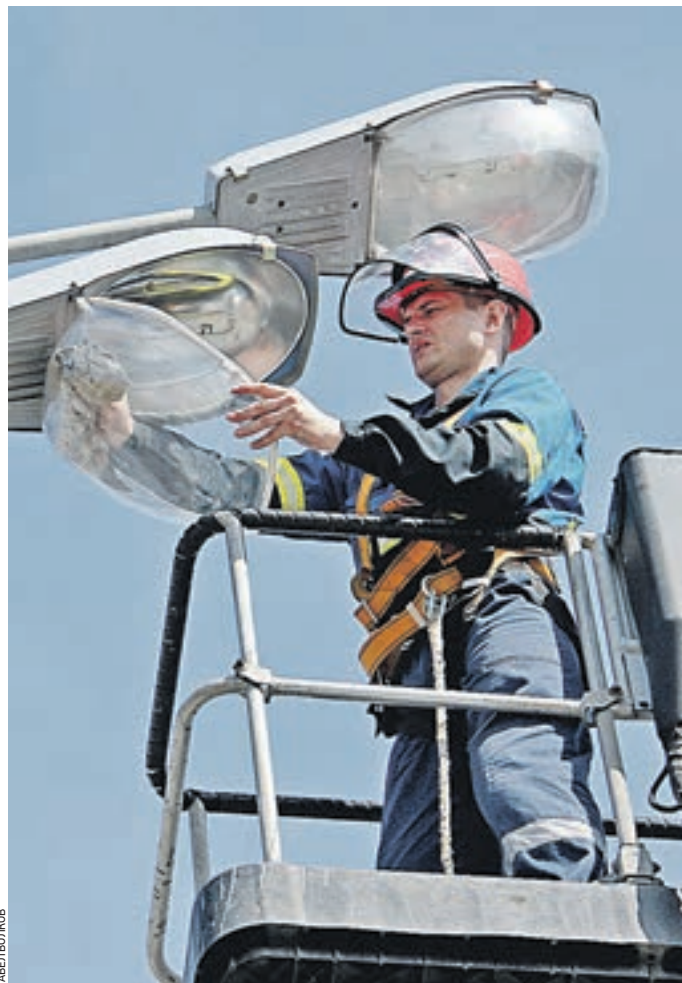
12 апреля 2016 года 11:20 Рабочий ОЭК Владимир Мартынов на 15-метровой высоте моет плафон фонаря на Варшавском шоссе
