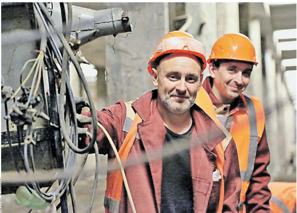
Вчера 12:15 Проходчик Алексей Кузин (слева) и подсобный рабочий Георгий Мельник работают на реконструируемой станции «Наховская». В настоящее время идет бетонирование платформы
