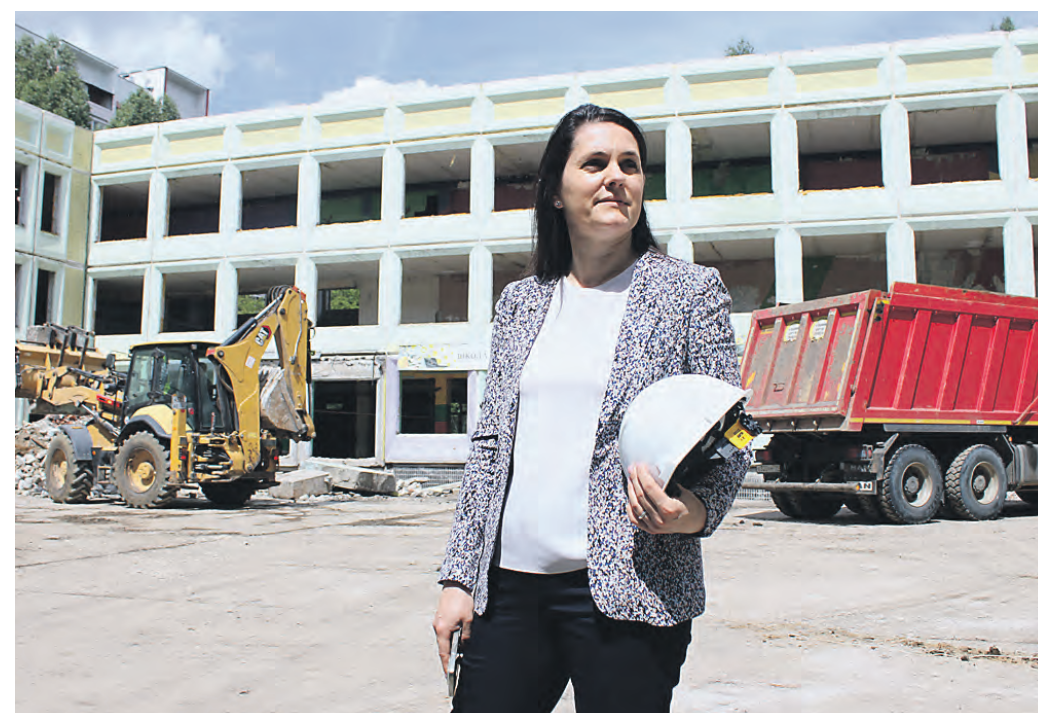
19 июня. Директор Школы в Капотне Ирина Ульянова проверяет ход работ по капитальному ремонту одного из корпусов. Здание обновят по современному стандарту. Фото: Мария Хапцова
