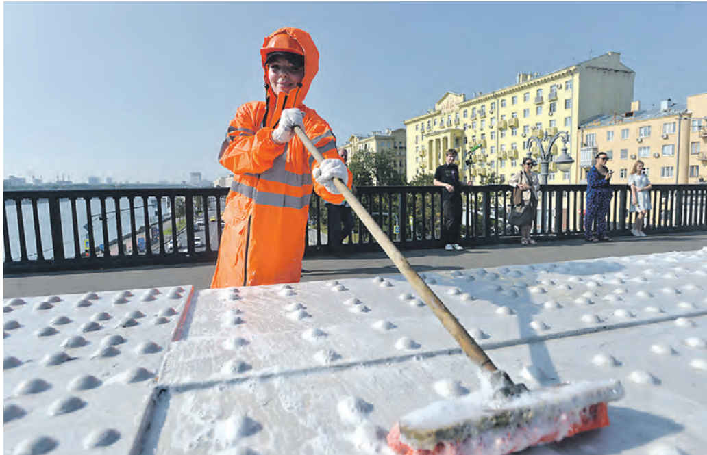
28 августа. Дорожный рабочий ГБУ «Гормост» Елена Рябина специальным составом очищает стальные элементы Крымского моста. Фото: Александр Кочубей
