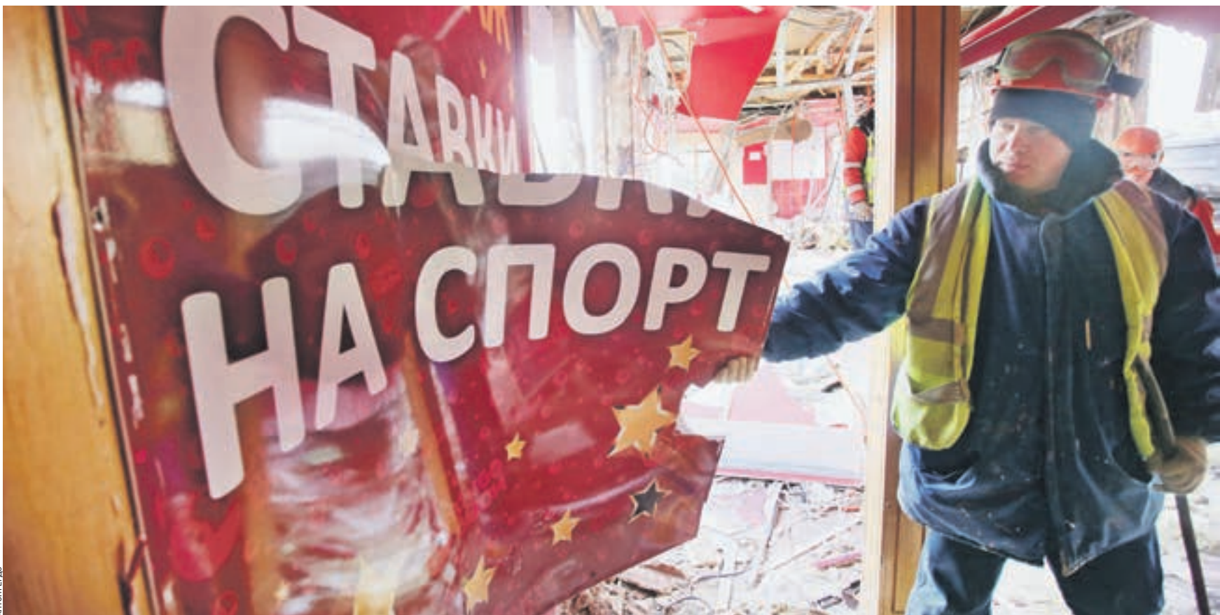
9 февраля 2016 года 14:15 Бригада государственного бюджетного учреждения «Горюст» сносит незаконные постройки, расположенные над пешеходным переходом через проспект Мира возле станции метро «Алексеевская». В конце августа демонтируют еще 84 самостоера, находящихся в охранной зоне метрополитена
