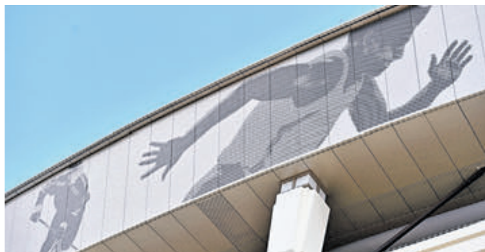
► Исторические фасады Большой спортивной арены бережно сохранили
