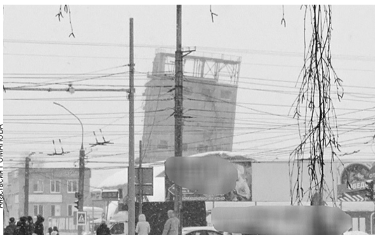
Второе сооружение накренилось, но осталось стоять.
