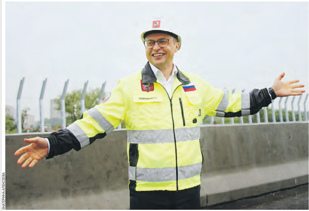
Вчера 15:45 Руководитель Департамента строительства Рафик Загрудинов оценил, как идет работа по строительству моста через реку Пехорку
