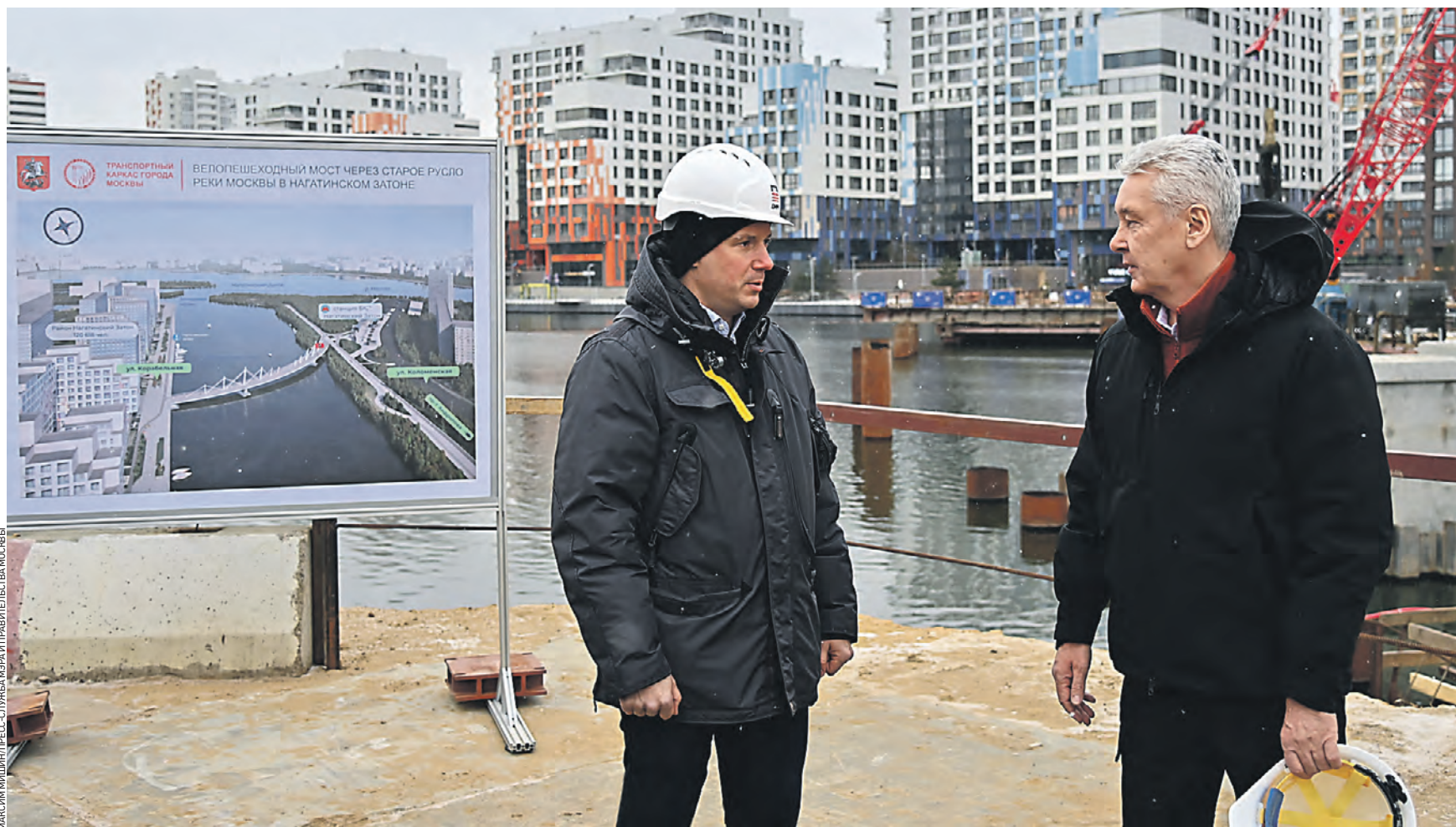
21 ноября. Мэр Москвы Сергей Собянин (справа) и первый заместитель генерального директора компании-подрядчика АО «Дороги и мосты» Владимир Волков осматривают ход строительства велопешеходного моста в Нагатинском Затоне. Он откроется в следующем году и станет визитной карточкой Южного округа
